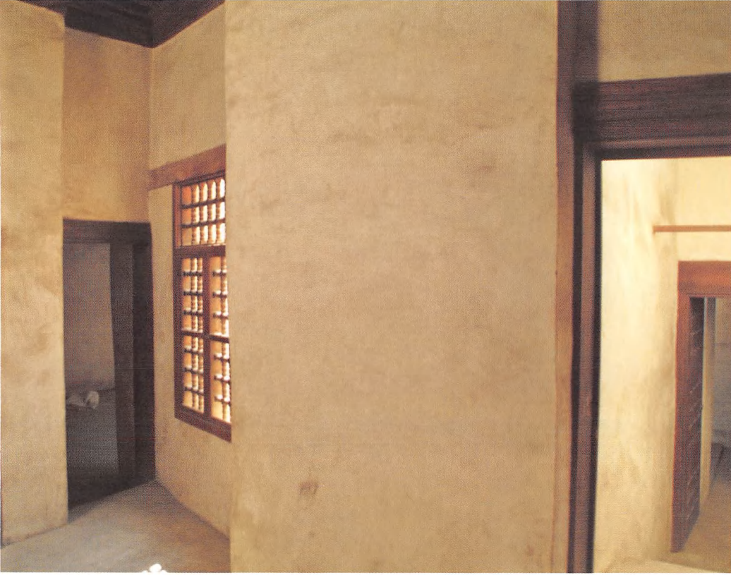
(لوحة 81) الفسحة التي تتوزع حولها غرف قسم الحرم بالدور الأول، ويظهر يمين الصورة باب سلم الفناء الثانوي، ويسار الصور يظهر الميل في جدار الفناء الثانوي بهذه الجهة لتوفير مساحة لباب إحدى الغرف.
